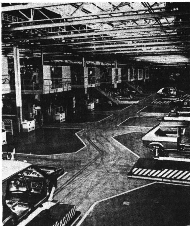
*Karosserieaufbauten, die vom Robocarrier entlang den Schweißstationen des Robogate-Systems bewegt werden.*
